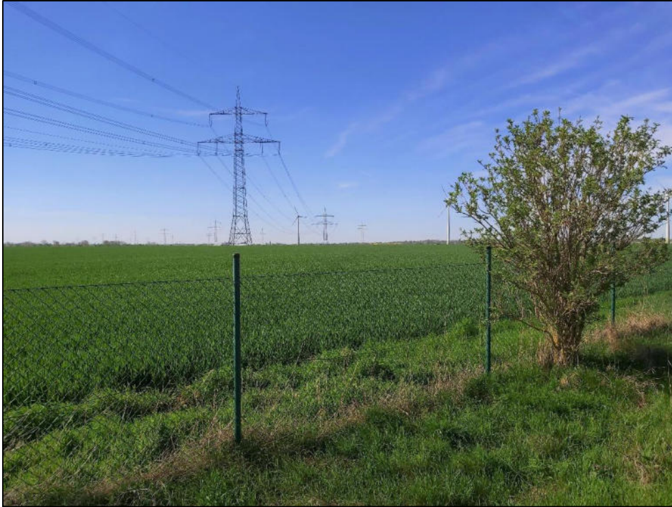
Abb. 7: Südlicher Teil des geplanten Windparks mit Hochspannungsfreileitung, Blickrichtung Südwest.
