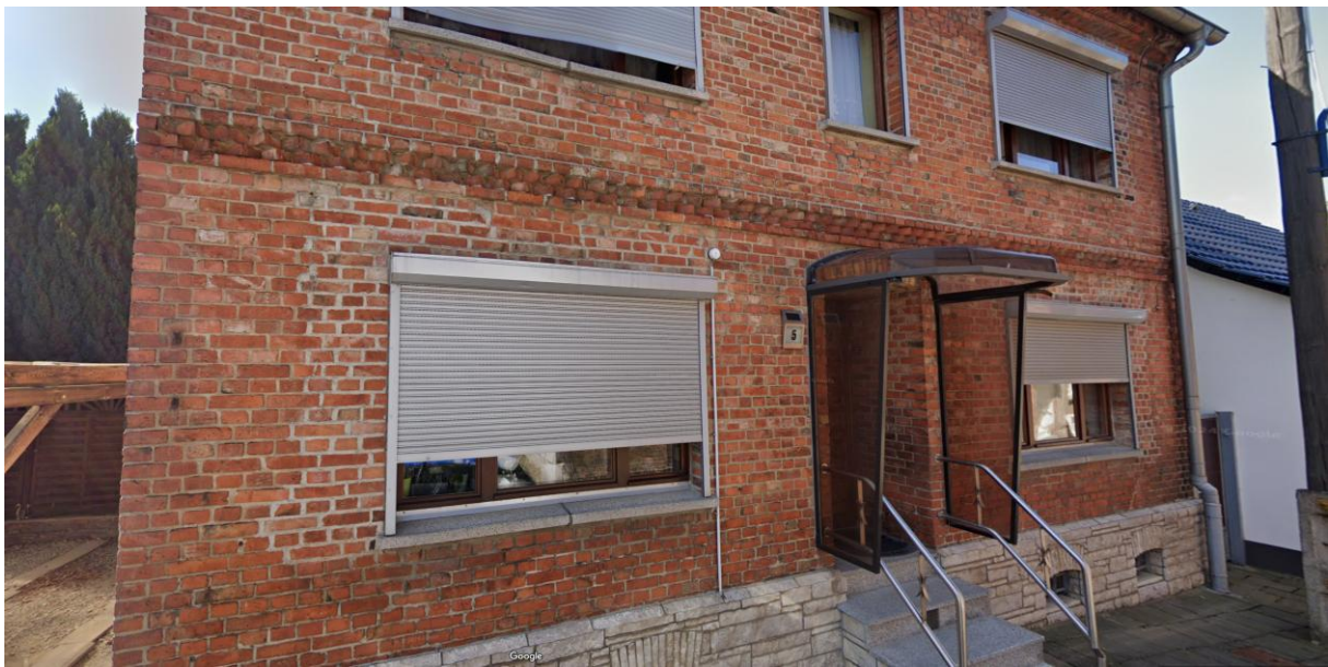
Abbildung 20: freistehendes Einfamilienhaus (Baujahr ca. 1900) in Ziegelbauweise
