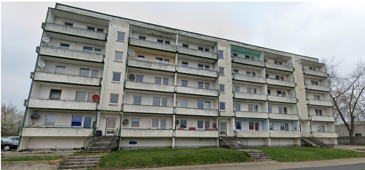
Abbildung 17: freistehendes Mehrfamilienhaus (Baujahr ca. 1970) in Plattenbauweise
