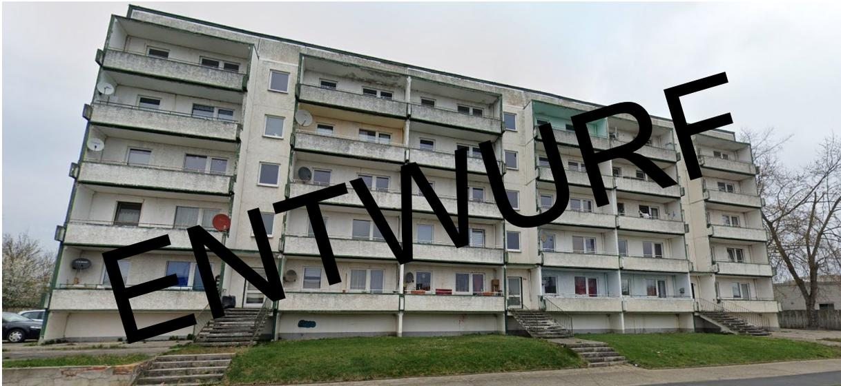
Abbildung 17: freistehendes Mehrfamilienhaus (Baujahr ca. 1970) in Plattenbauweise
