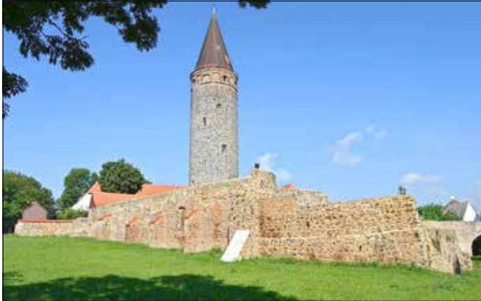
Schloss Zöbzig - Ansicht der Burganlage mit Burg- bzw. Schlossturm (SAW)
